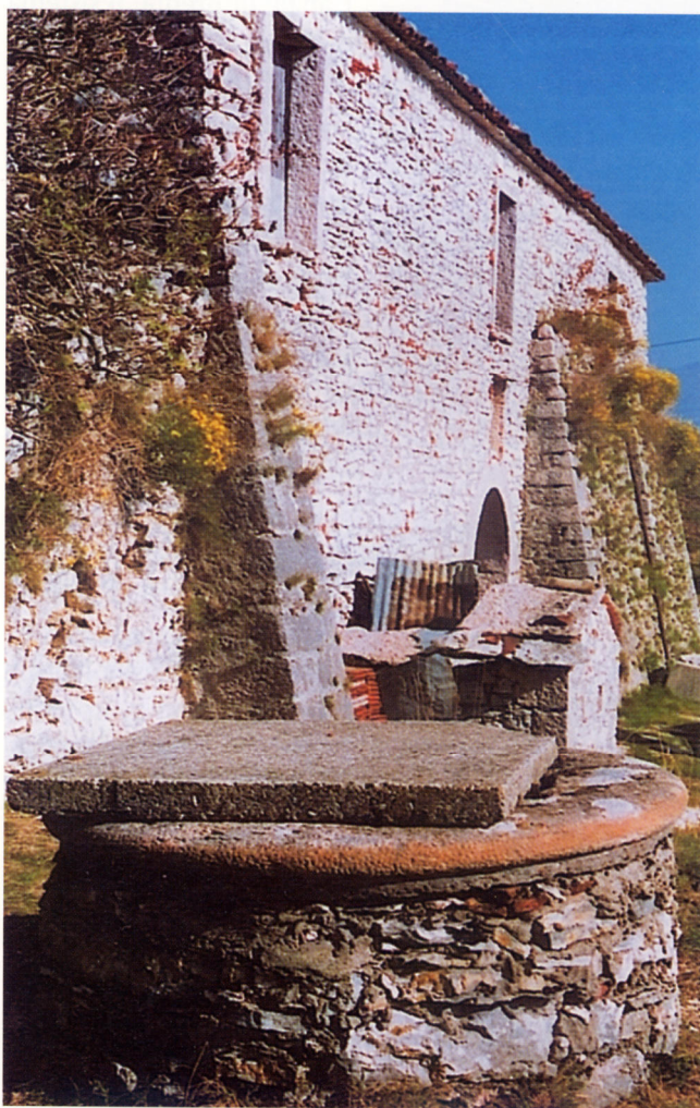
③ La facciata sud del Palazzon con in primo piano il pozzo d'acqua in pietra
