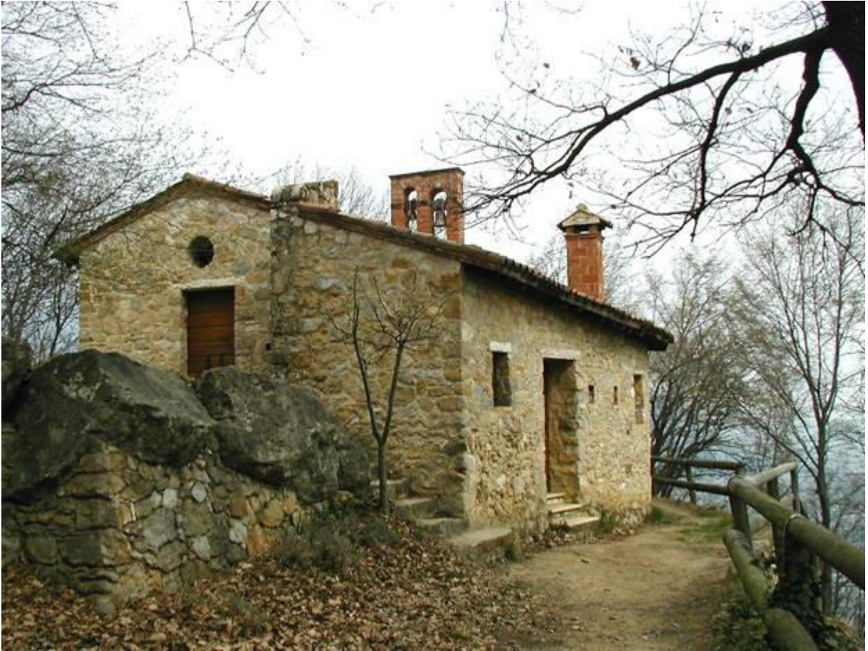
Eremo di San Bovo (Bassano). Cella e chiesa dopo la ricostruzione.
