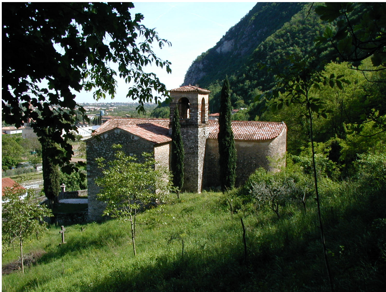
Veduta da monte con la torre e le aggiunte settecentesche
