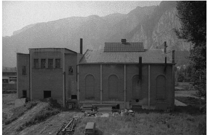
Centrale termica abbattuta
