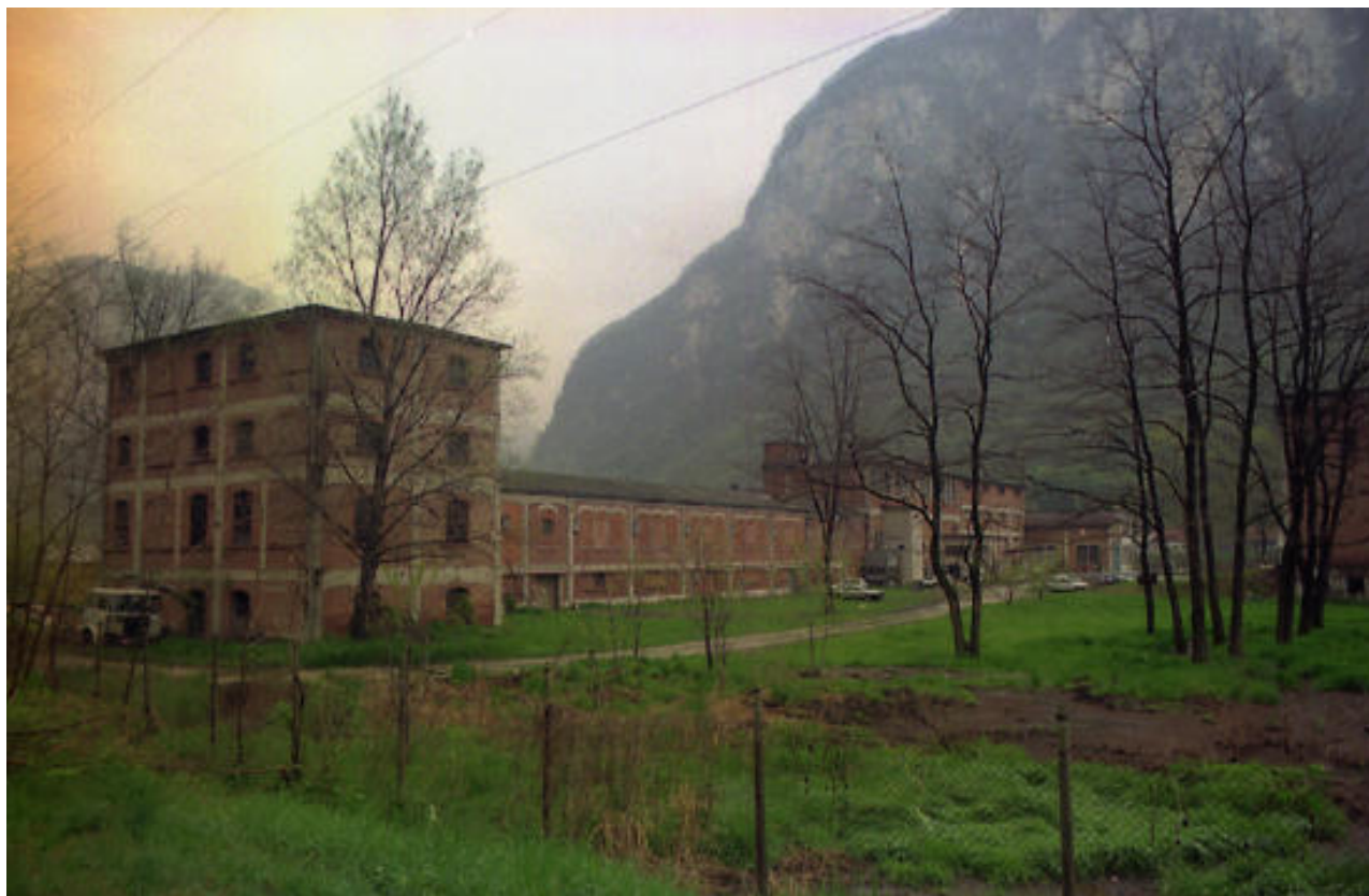
Edifici e officine abbattuti
