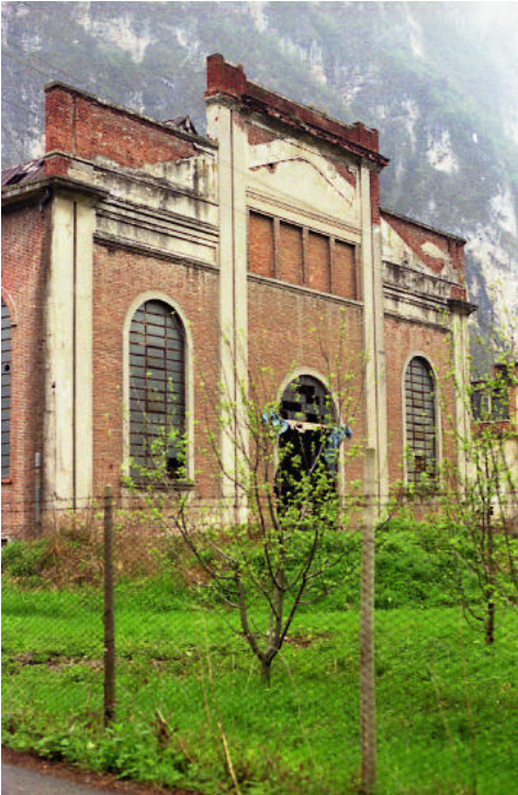
Facciata centrale termica abbattuta
