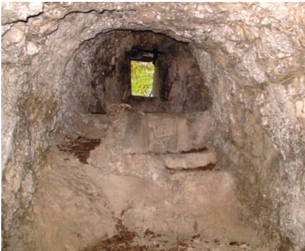
Postazione sotto roccia con gradino d'appoggio per mitragliatrice parzialmente ricoperto da materiale.
