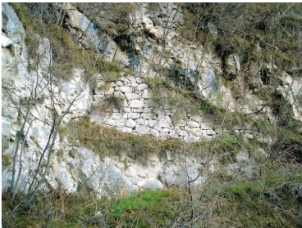
Massicciata in pietra a secco di sostegno alla mulattiera militare che segna il percorso della linea di sbarramento.
