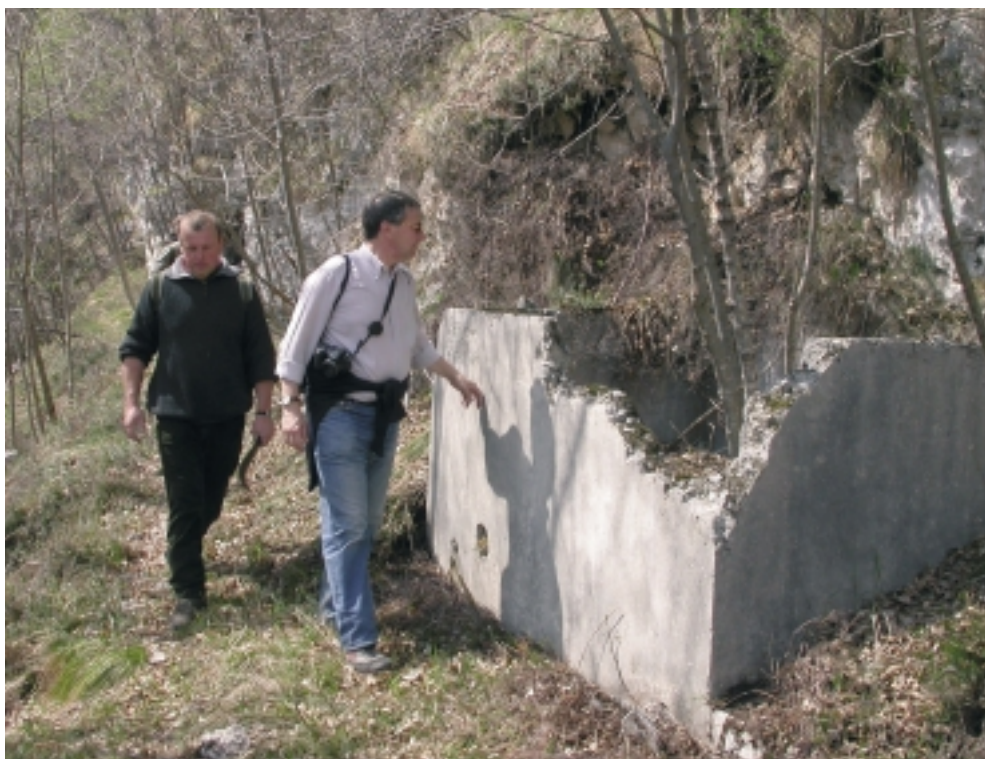
Serbatoio idrico invaso dalla vegetazione lungo la linea di sbarramento. Si noti l'angolo superiore sinistro, dove è visibile la traccia sul cemento lasciata probabilmente da una targa.
