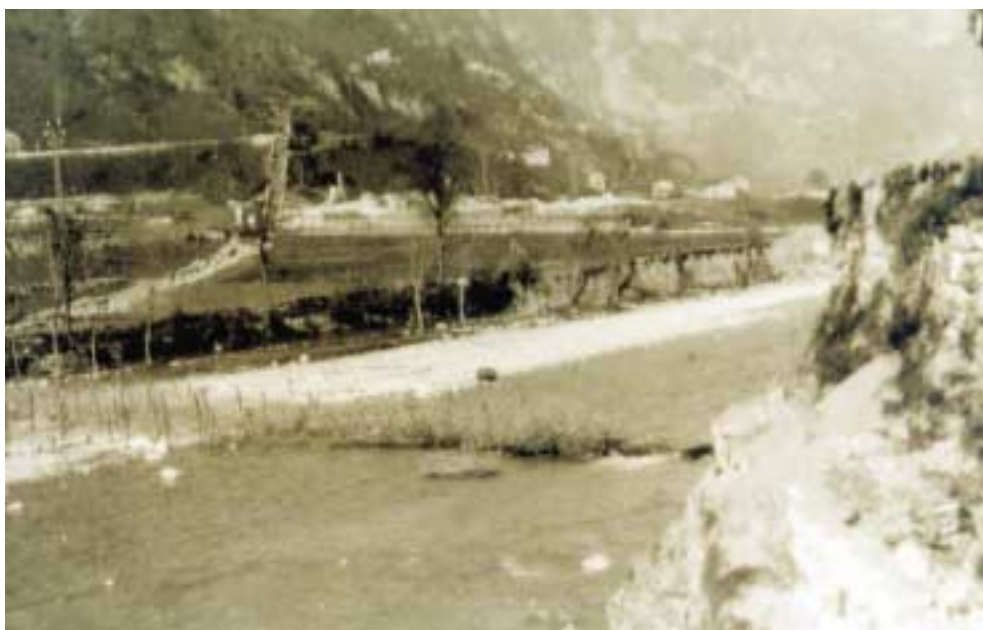
Immagini delle linee di sbarramento nel Canale di Brenta. Sopra, appostamenti nei pressi della Grottella; sotto, trincee e reticolati sul fiume all'altezza di San Gaetano. Nella pagina a fianco: sbarramento stradale a Rivalta di San Nazario.
