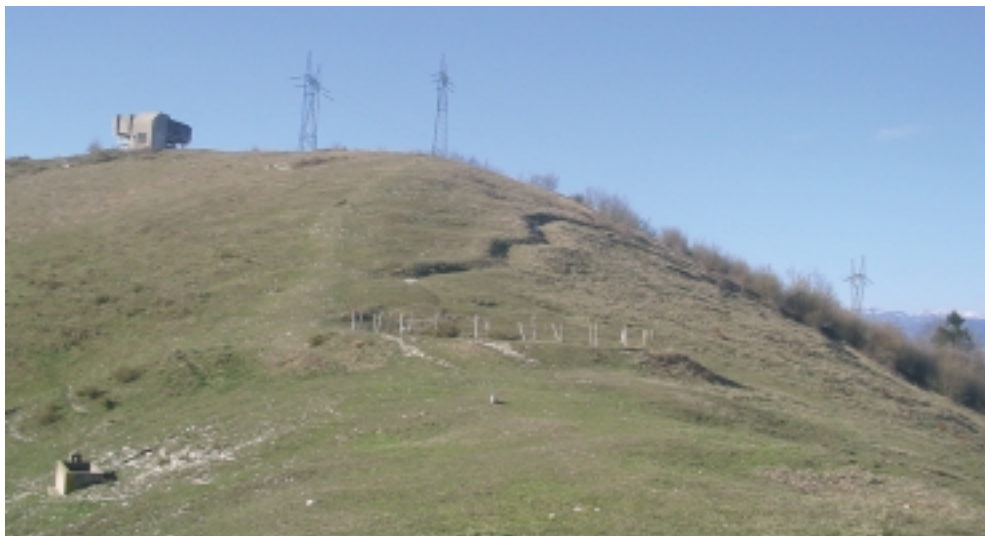
La sommità del Col d'Astiago (m. 1241) con il serbatoio dell'acquedotto sullo sfondo e il serpeggiare di una linea di trincea: molti dei manufatti bellici furono ricoperti per consentire la ripresa dell'attività d'alpeggio.
