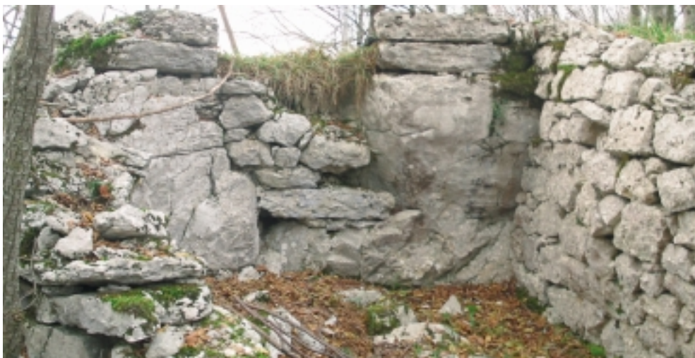
Costruzione in pietra a secco con feritoia nei pressi della Forcella di Val d’Ancino. La struttura è assai fragile, con pericolo di imminente crollo delle pareti.
