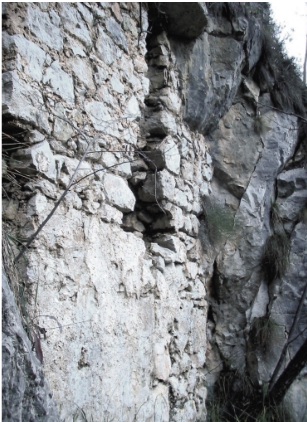
La muratura su roccia dove è ancora visibile la forma di una canna fumaria nei pressi di Le Pirche. Si è ipotizzata la funzione di cucina.
