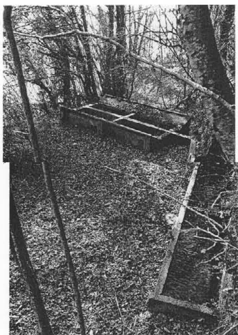
4. Costa Caorera, Quero, quota 625 metri: capiente cisterna di raccolta in pietra e cemento a insolita forma rettangolare, con rubinetto e scolo alla base.
