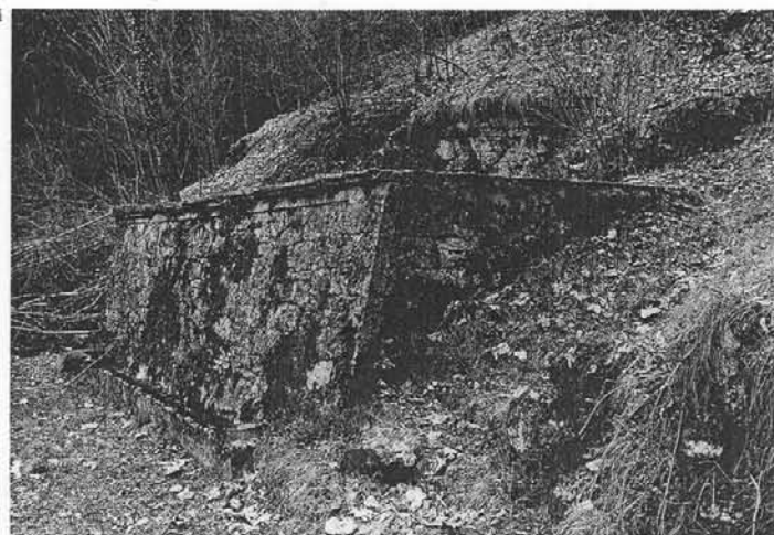
3. Pra Tondo, Valstagna, quota 460 metri: uno degli esempi meglio conservati di pozzo-cisterna seminterrato, tra i più diffusi sistemi di raccolta d'acqua nelle aree terrazzate del canale: queste poderose cisterne che possono raggiungere anche i 5-6 metri di profondità, sono alimentate in genere da un articolato sistema di condotte superficiali di raccolta delle acque piovane.
